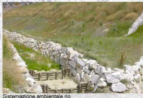
Sistemazione ambientale rio
