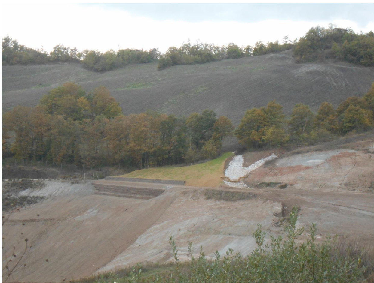
Fotografia 4. Fasi di lavorazione a valle terre rinforzate e panoramica complessiva dei lavori nell'area del dissesto D1 [foto Bonini settembre 2019]
