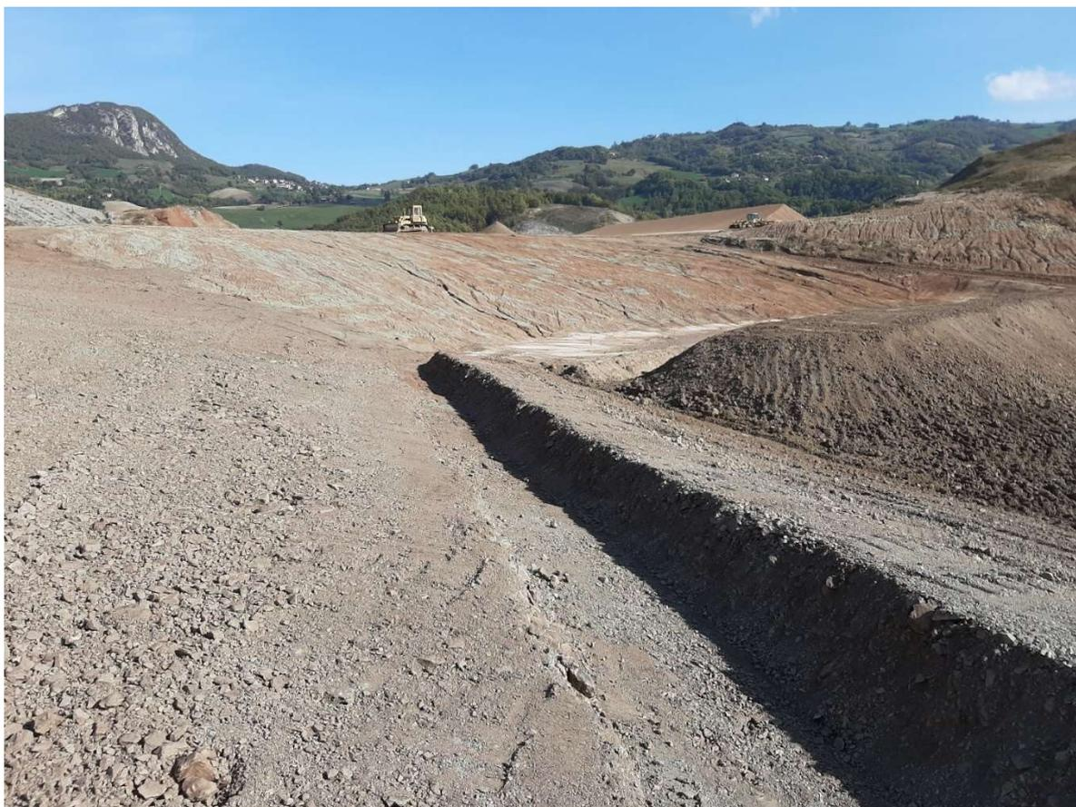
Foto 23. Fronti di cava in lavorazione con realizzazione di opere di regimazione idraulica.
