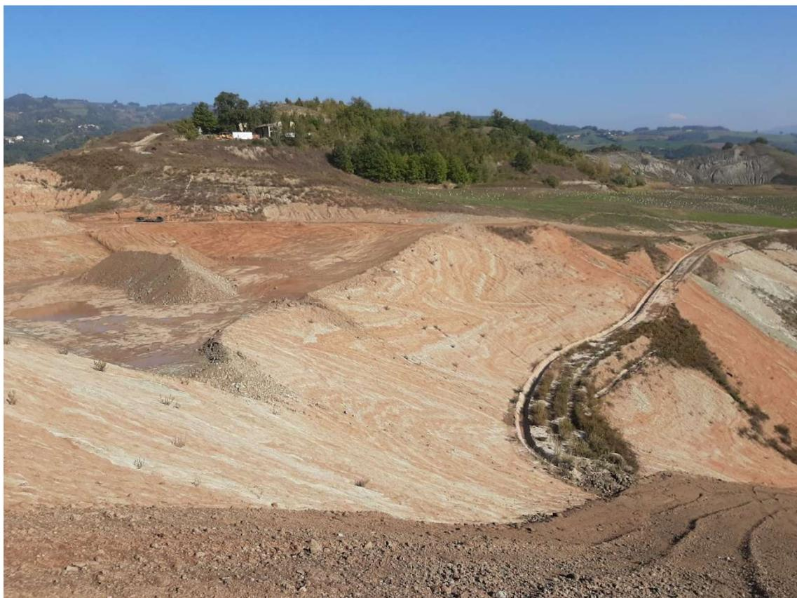
Foto 25. In primo piano le lavorazioni di coltivazione e sistemazione morfologica della cava. Sullo sfondo l'area di M. Quercia di sotto e gli interventi di rimboschimento realizzati, visti dal versante opposto.
