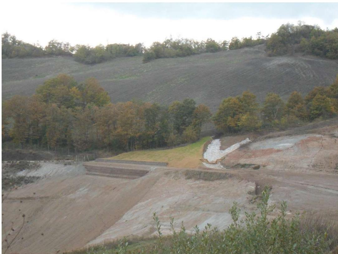
Foto 20. Vista sugli interventi di sistemazione morfologica idraulica e vegetazionali completati nel 2019 nel settore occidentale della cava. Per una descrizione dettagliata si veda l'elaborato R.2.1. Si osserva il rinverdimento realizzato a monte delle terre armate con ricostruzione di un prato tramite la tecnica della stesura di fieno sotto biorete.
