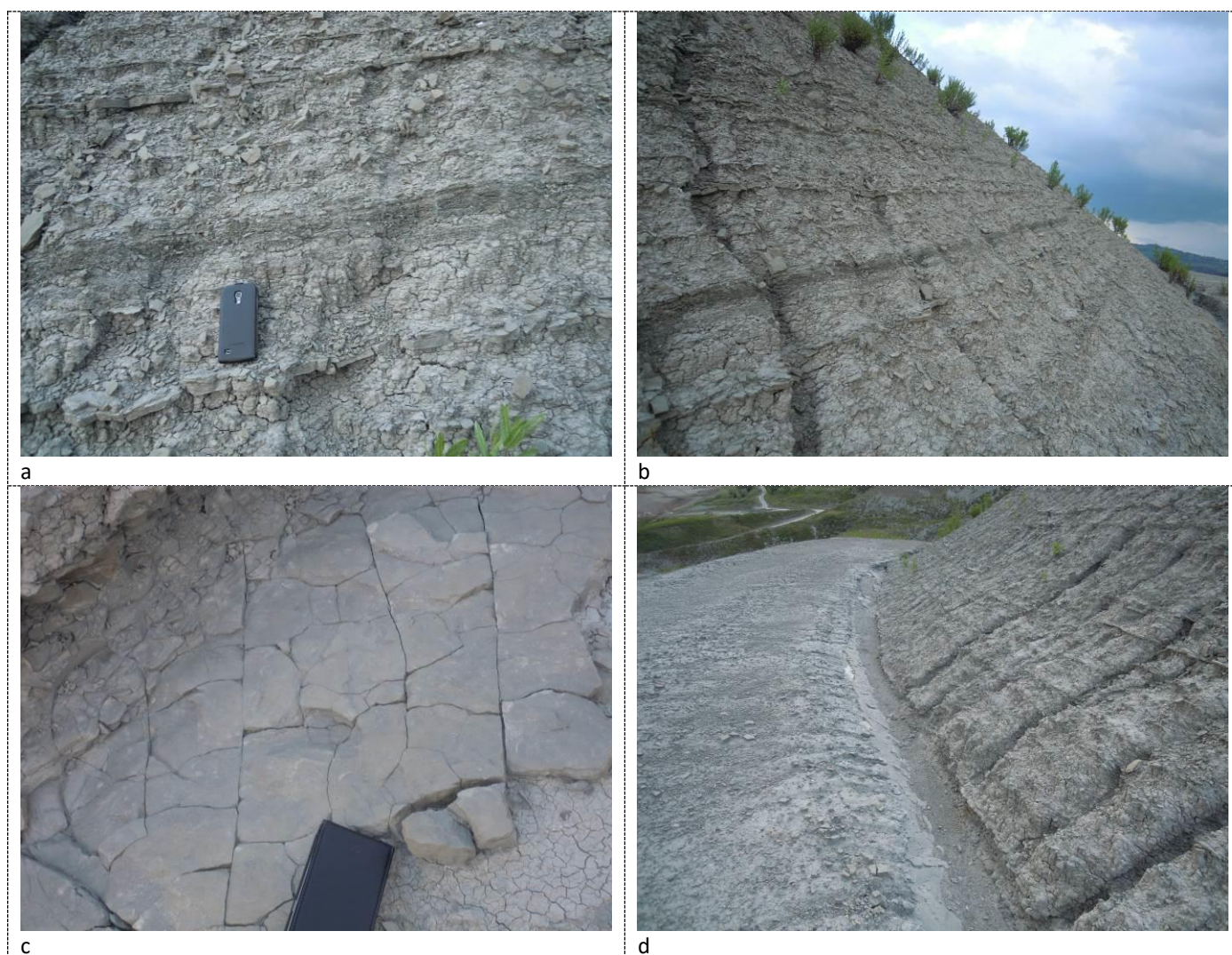
Figura 20. Assetto strutturale tipico nella zona di confine tra le cave M.te Quercia e Molino di Canevarola. Giacitura 35-40° con disposizione reggipoggio e leggero traversa poggio. In c) livello arenaceo spessore 3-4 cm disposto a reggipoggio con fatturazione k_1 ortogonale alla giacitura e sistema trasversale a k_1 ( k_2 ) ad andamento non lineare. Le superficie di strato presentano ondulazioni laterali. Il rapporto A/P in tale sezione è circa 1/4 - 1/5 (in a: 14 cm/60 cm).
