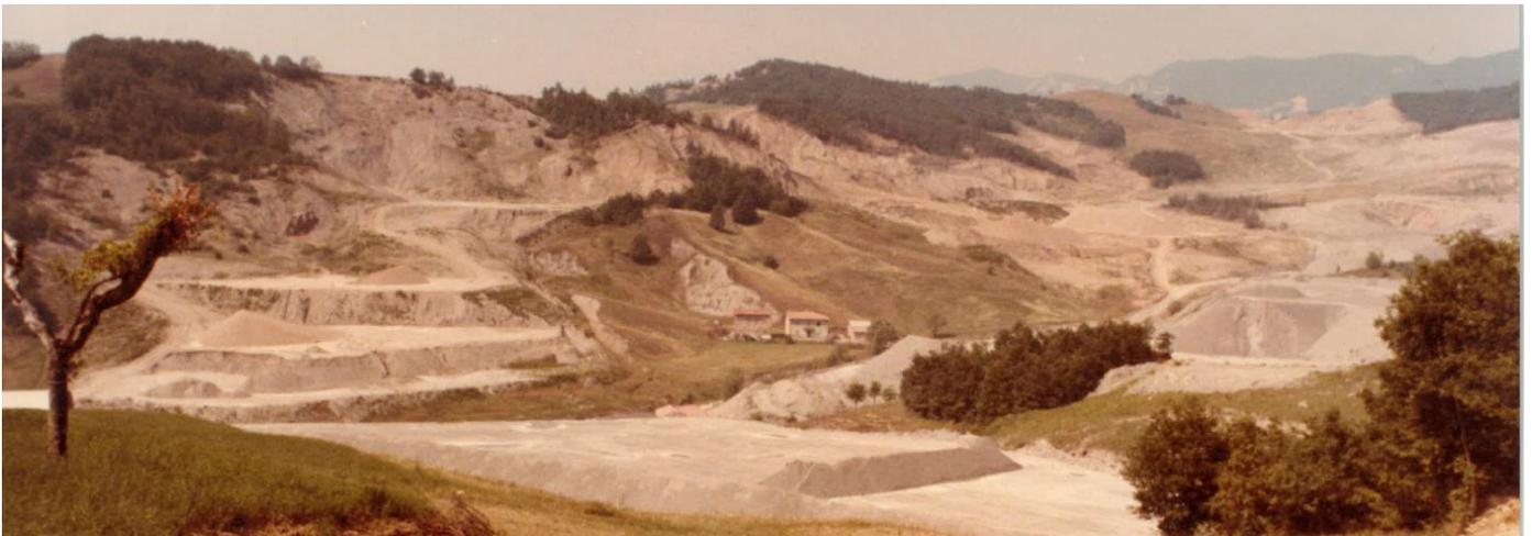
Figura 21. Fotografia storica (pre 1996) della cava Braglie dove si nota la presenza del fronte di cava (argille MMP) a monte dell'abitato Le Braglie e due aie di stoccaggio e lavorazione a valle dell'abitato ed al piede del attuale frana R3
