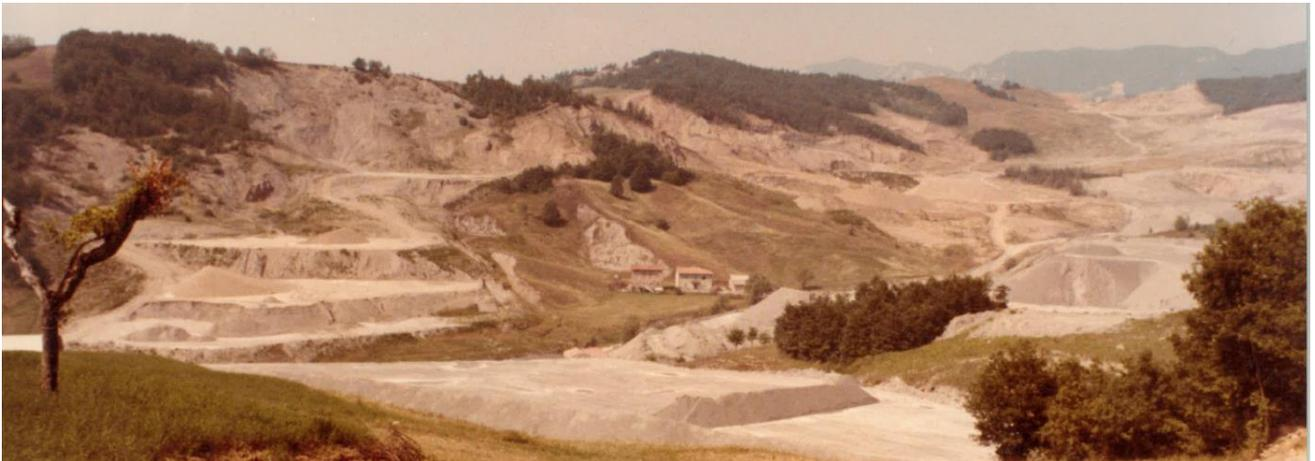
Figura 11. Fotografia storica (pre 1996) della cava Braglie dove si nota la presenza del fronte di cava (argille MMP) a monte dell'abitato Le Braglie e due aie di stoccaggio e lavorazione a valle dell'abitato ed al piede dell'attuale frana R3.
