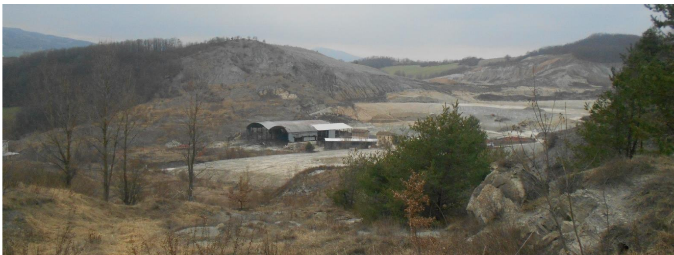
Figura 7. Fotografia dell'area della frana A3 (foto Donati marzo 2021), vista dal versante opposto.
