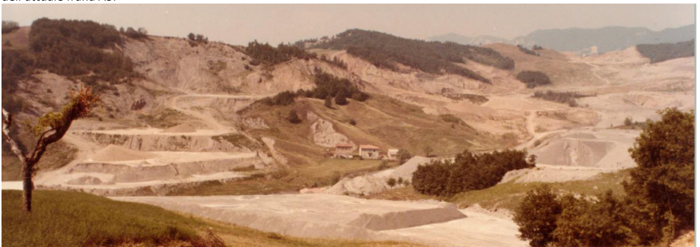
Figura 5. Fotografia storica (pre 1996) della cava Braglie dove si nota la presenza del fronte di cava (argille MMP) a monte dell'abitato Le Braglie e due aie di stoccaggio e lavorazione a valle dell'abitato ed al piede dell'attuale frana R3.
