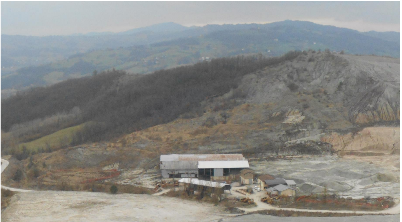
Figura 8. Fotografia dell'area della frana A3 (foto Donati marzo 2021).
