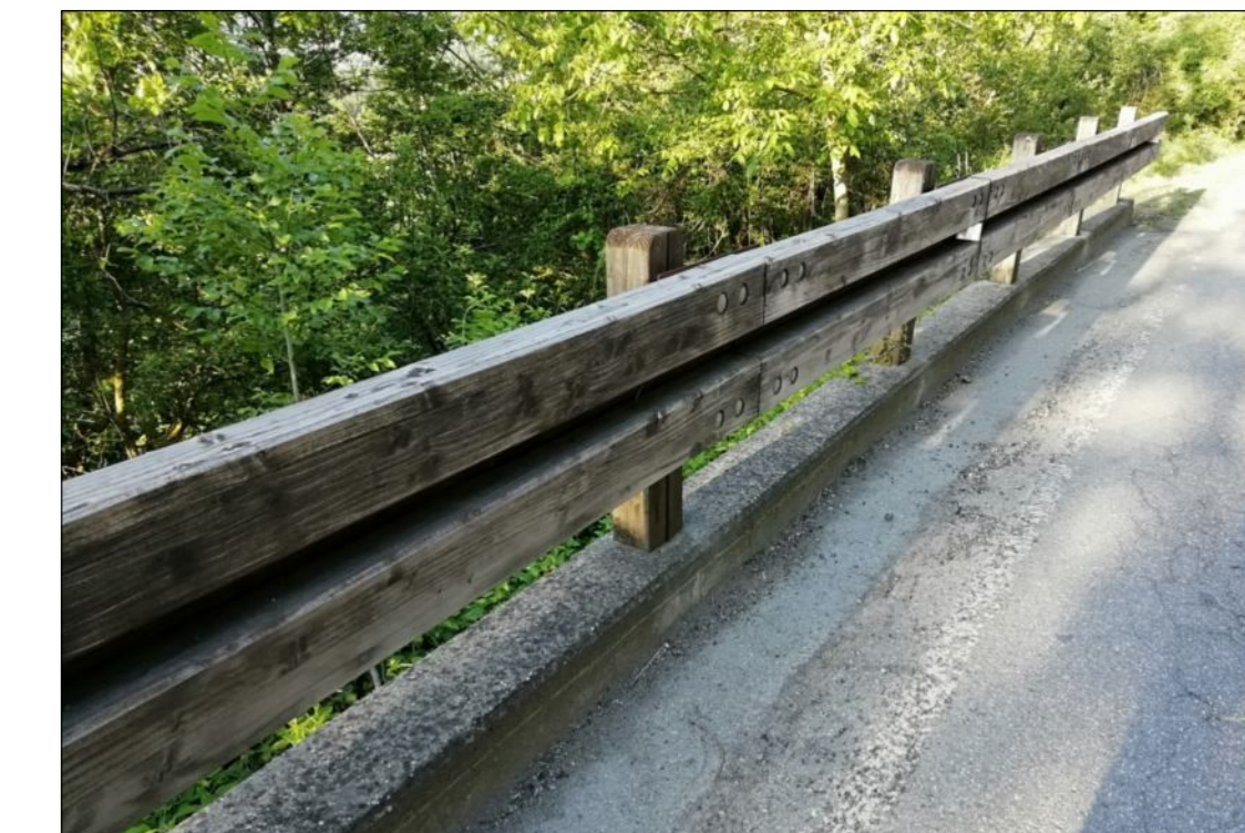
ESEMPIO BARRIERA DI SICUREZZA DA REALIZZARE
